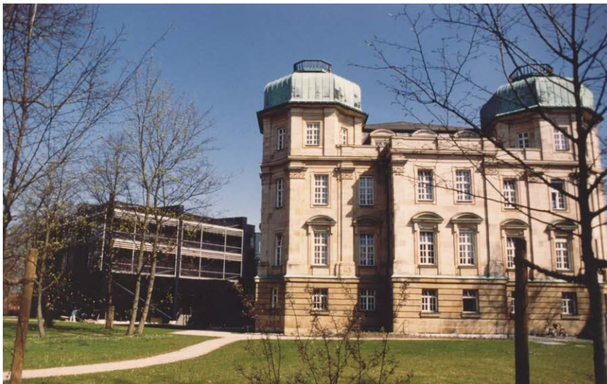
Südfront des Bundesfinanzhofs mit modernem Anbau an der Rückseite
